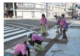
道路清掃の様子
